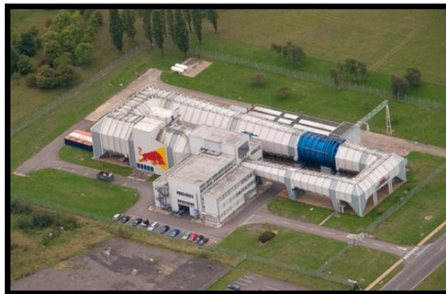
Figura 2.4: Túnel de vento circuito fechado Red Bull – F1 – UK. Fonte: Red Bull – F1.
