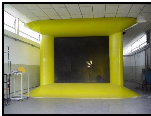
Figura 4.4: Tela na Seção de Entrada. Fonte: Túnel aberto - CTA – ITA.
